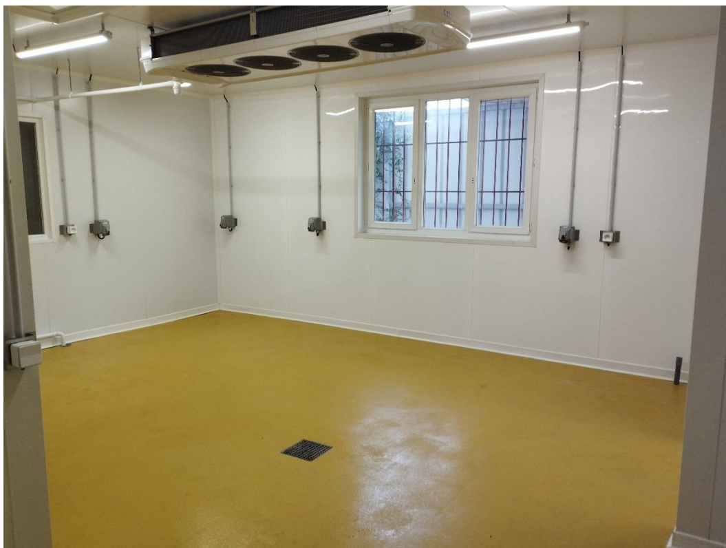
Zone de production réfrigérée n°2
