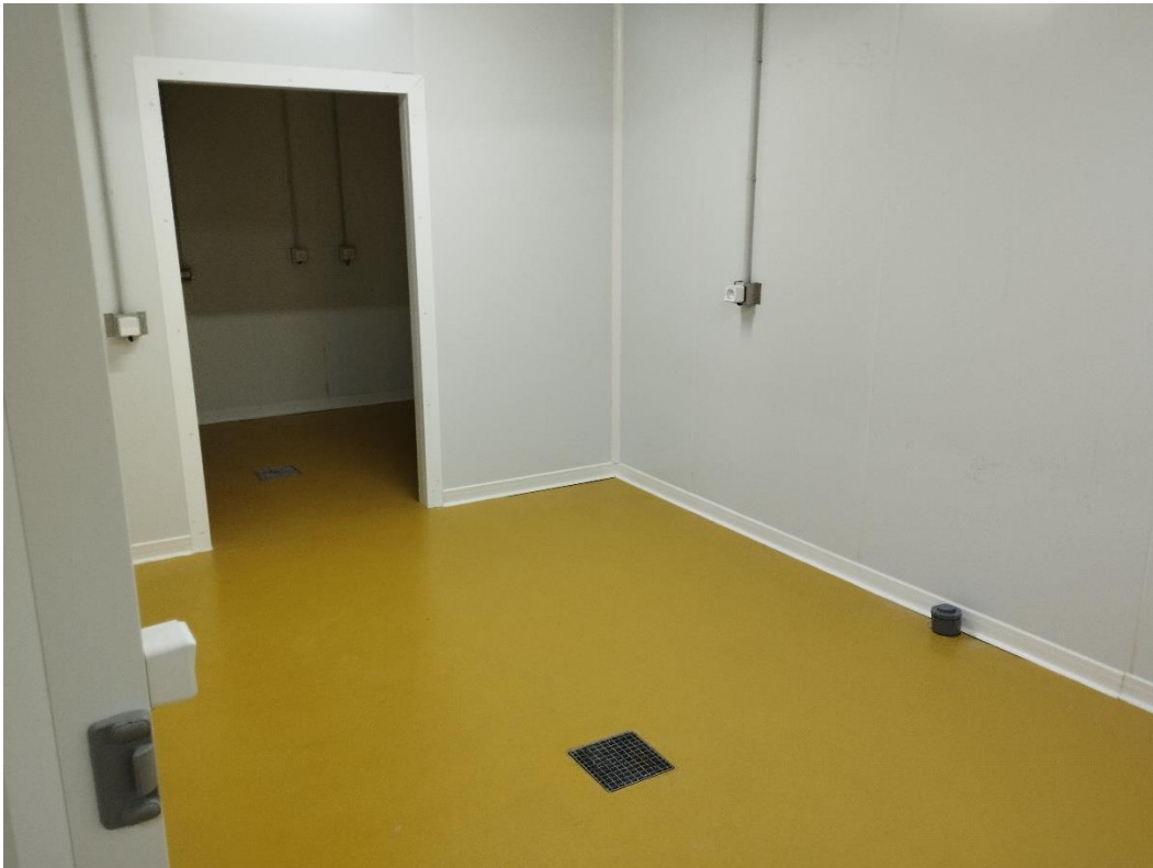
Zone de production réfrigérée n°1
