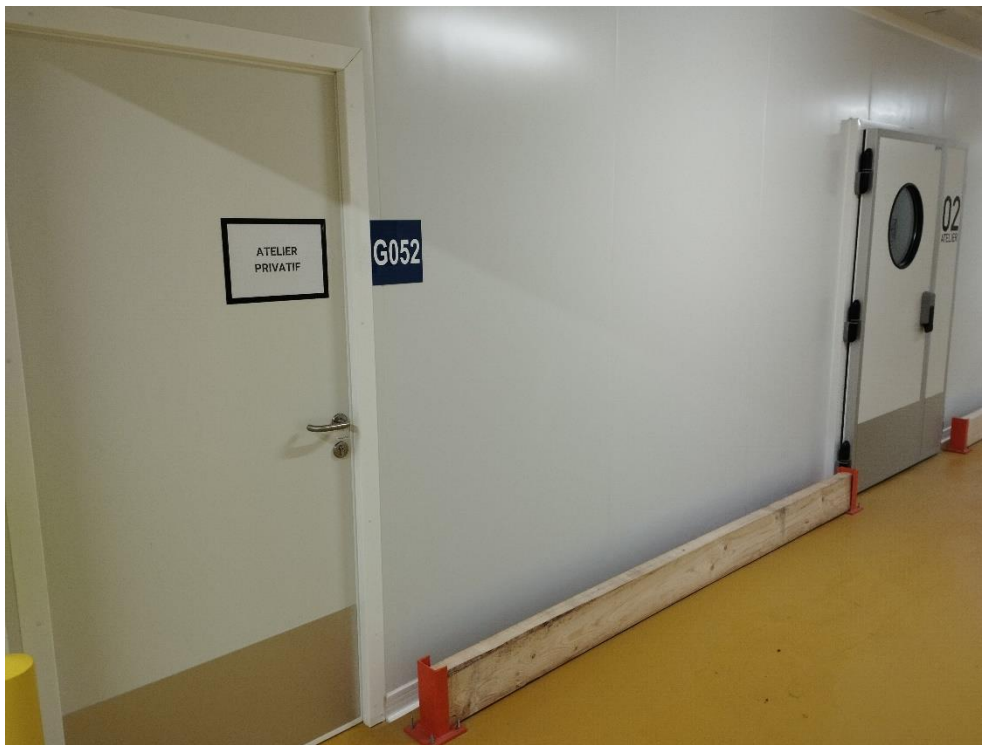
Entrées personnel (gauche) et matières (droite)
